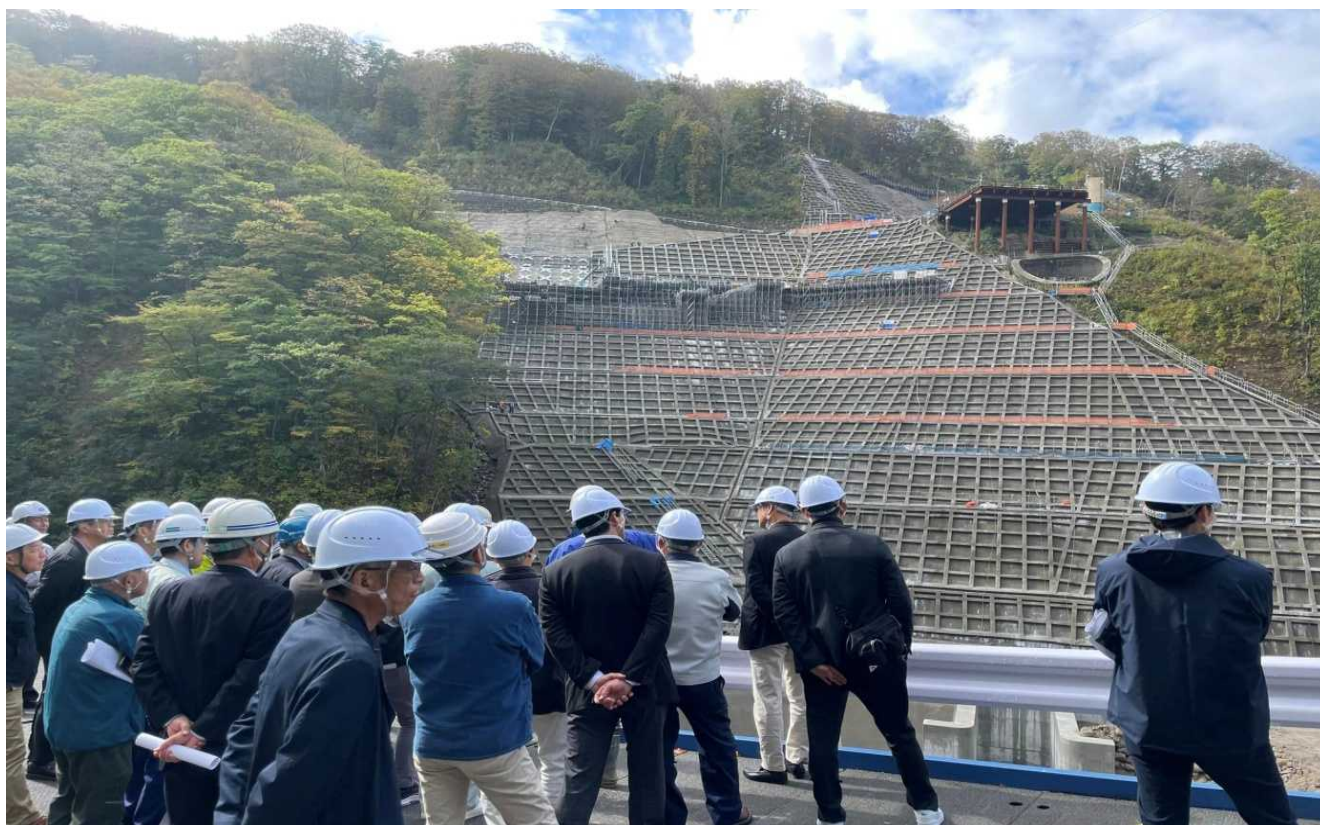
駒込ダム ダムサイト①
