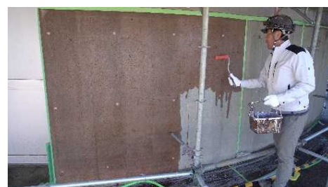
退色着色工法 施工
