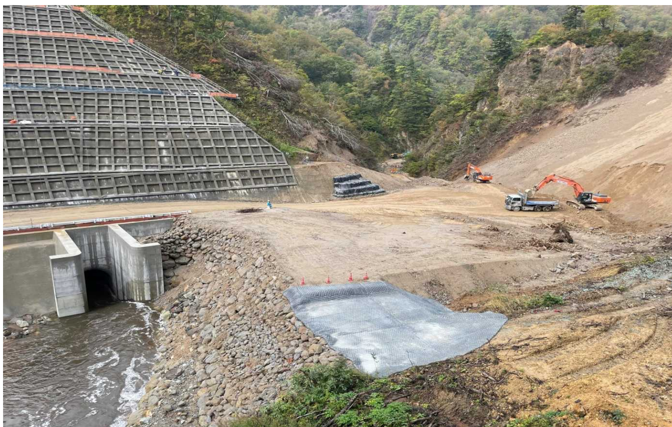
駒込ダムダムサイト②
